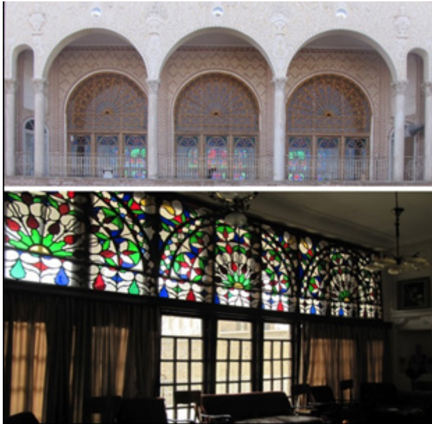
تصویر ۴- (بالا) ارسی سه لنگه با کتیبه نیم‌دایره در طنبی خانه قدکی تبریز، (پایین) ارسی نه لنگه با کتیبه تخت و ترکیب‌بندی دایره‌ای شکل در خانه نقشینه تبریز (نگارندگان).
