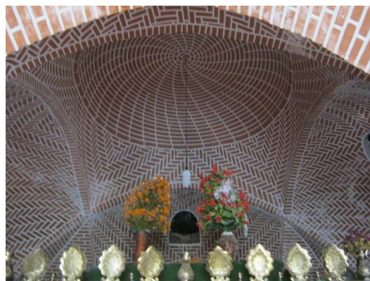
تصویر ۵: نیم کاسه‌های قوسی برای اجرای پوشش سقف امامزاده اسحاق (نگارندگان)
